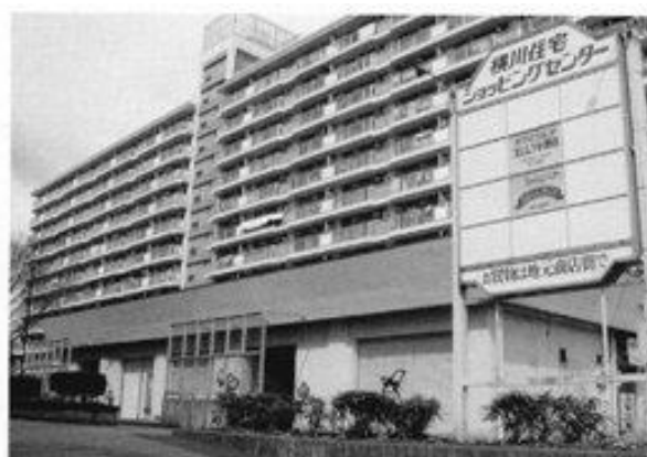
写真3 八王子教室建物
